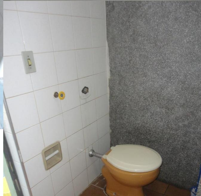
Válvula quebrada, vazamento de água, espelhos quebrados, piso e azulejos antigos.
